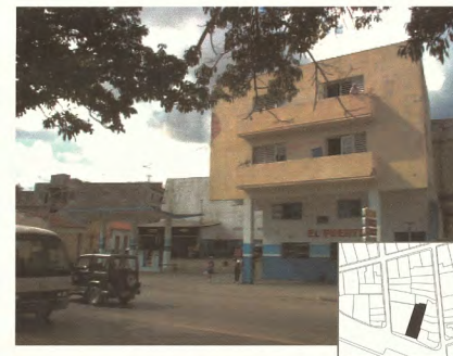
Dirección: Calle San Pedro No. 516 e/ Merced y Jesús Uso original: María. Uso actual: Vivienda. Estado Técnico Constructivo: Mixto. Estación de gasolina, taller de autos y vivienda. Descripción: Bueno Superficie ocupada: Siglo XX. 3 plantas Superficie construida: 340 m 2 680 m 2
