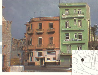
Dirección: Calle San Pedro No. 715 esq. Paula Uso original: Mixto, vivienda/comercio Uso actual: Vivienda social Estado Técnico Constructivo: Regular Descripción: Ecléctico (Neocolonial). Siglo XX. 3 plantas. Superficie ocupada: Muros mampostería, viga y losa. Superficie construida: 106 m 2 424 m 2
