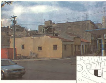
Dirección: Calle San Pedro e/ Merced y Paula Uso original: Edificio desaparecido. Uso actual: Parque. Estado Técnico Constructivo: En construcción. Descripción: Será un parque para uso de la comunidad con profusión de áreas verdes y de descanso. Podrá albergar diferentes actividades pasajeras como fiestas, ísimbolas, ferias, etc. Superficie ocupada: 440 m 2 Superficie construida: Área libre.
